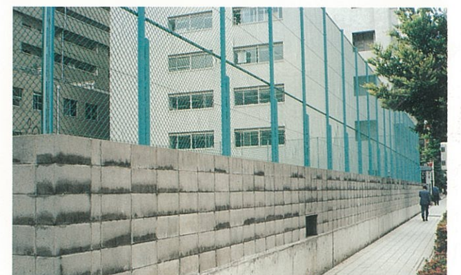
ブロック塀やフェンスは、まちなみを断絶してしまいます…。
