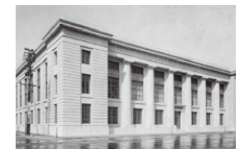
横浜正金銀行神戸支店の外観
