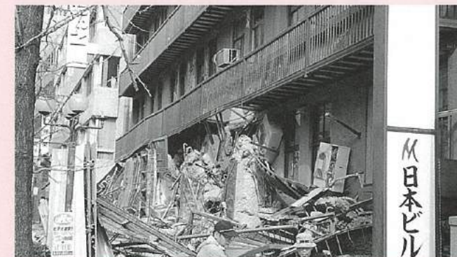
阪神・淡路大震災によってどのビルも大きな被害を受けた(日本ビルディング)
